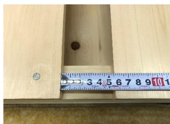
6 約5.6cm間隔で上板を止めていきます。 (オプションで上板を追加した場合は、約2.5cm間隔になります。)
