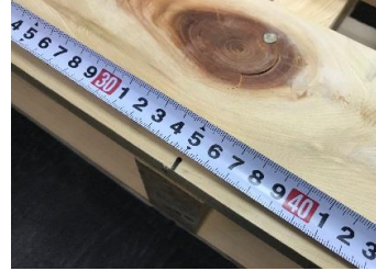
4 上板35cmに印を付け、真ん中の桁の芯と合わせて下さい。
