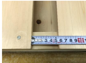
6 約5.6cm間隔で上板を止めていきます。
