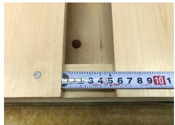
6 約5.6cm間隔で上板を止めていきます。
