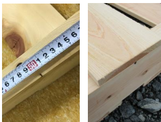
10 桁の50cmの所に印をつけて上板の真ん中と50cmの所で釘で止めて下さい。
