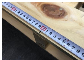
4 上板40cmに印を付け、真ん中の桁の芯と合わせて下さい。
